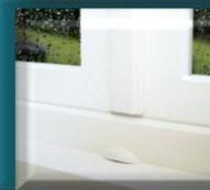
Les trous d'évacuation d'eau situés sur la traverse basse des menuiseries sont nécessaires à l'écoulement des eaux de ruissellement. Ils sont soit visibles, soit protégés par des busettes. Il est nécessaire de les nettoyer régulièrement afin qu'elles ne s'obstruent pas.
